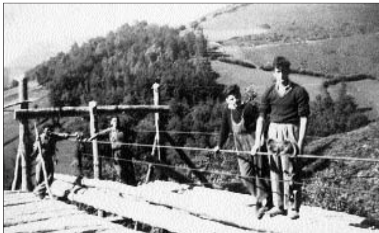
Egur kablearen zenbait elementu ikusgai: pilona, kableak eta karriloa.
